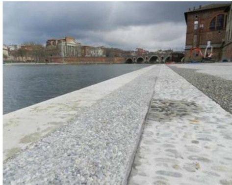
La calade en galets sur cette berge de l'Escaut constitue une alerte efficace du danger proche (source : Communauté urbaine de Dunkerque)
