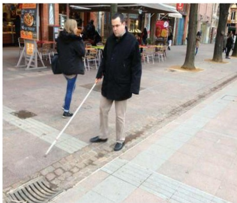
Ligne de guidage offerte par le caniveau (source : Communauté urbaine de Dunkerque)
