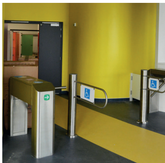
Installation d'une signalétique adaptée à la piscine Lothaire
