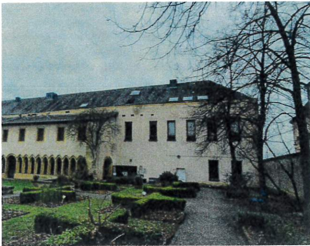
Vue de la façade nord de l'aile est
