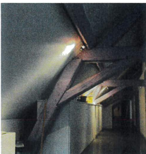
Vue de la charpente principale de l'aile est
