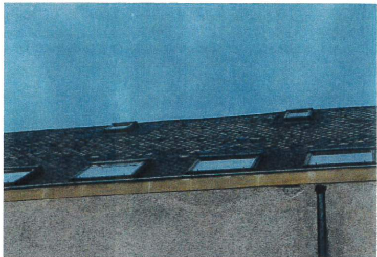
Vue des châssis de toit au sud de l'aile est
