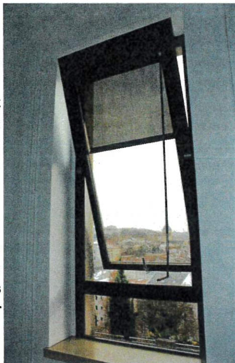
Menuiseries de la façade sud de l'aile est
