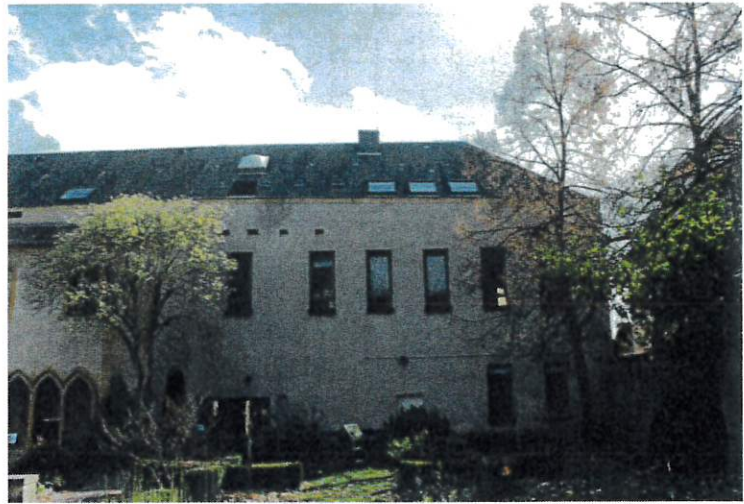
Vue de la façade nord de l'aile est
