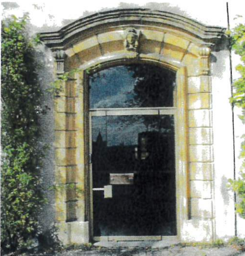
Vue de la porte d'entrée de la façade sud
