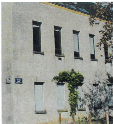
Vue des menuiseries de la façade sud de l'aile est
