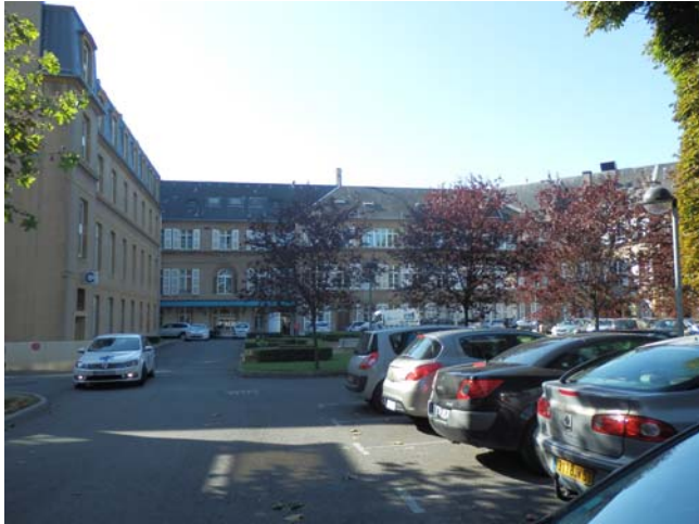
Partie nord de la grande cour (1 et 2)
