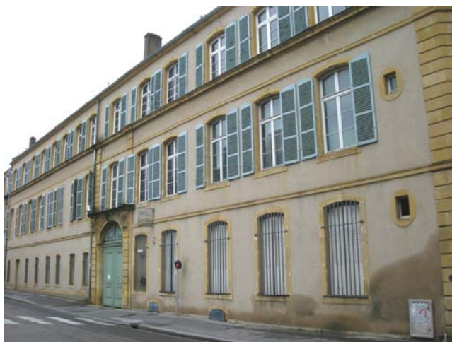
Façade du 4 rue Châtillon (1)
