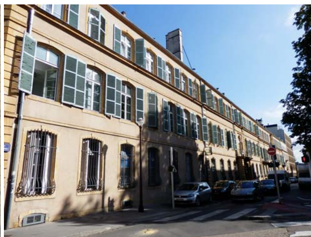
Façade sur le rempart Saint-Thiébault (1, 2 et 3)
