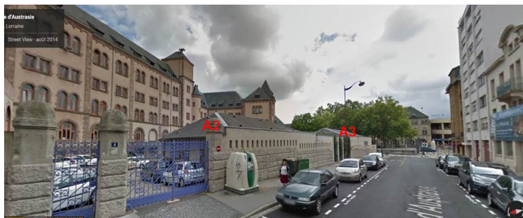
Rue d'Austrasie, vue de la cour C1 et des annexes A2 et A3 adossées à la clôture sur rue
