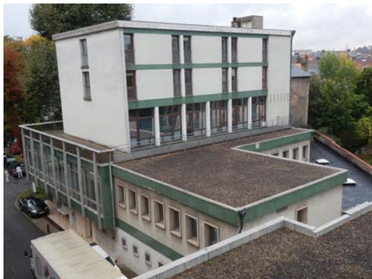
Bâtiment récent (années 1960) du fond des parcelles 150 et 149 (4)
