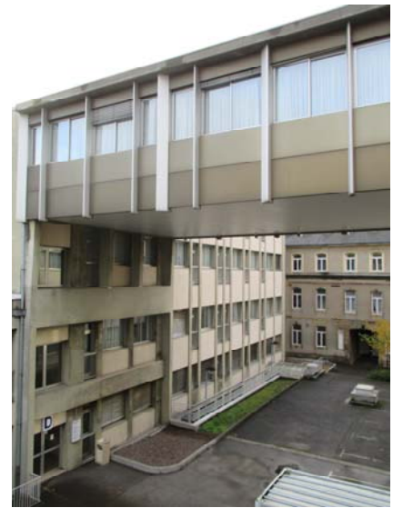
Cour du troisième hôtel (3), au premier plan la passerelle (3bis)
