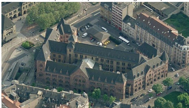
Vue aérienne oblique. © Bing
