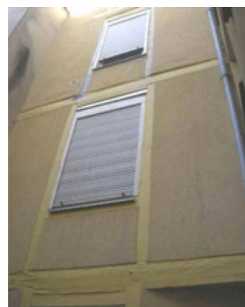
Exemple d'extension en pan de bois construite sur cour à la fin du XIX e siècle ou au début du XX e siècle (5 rue des Parmentiers).
