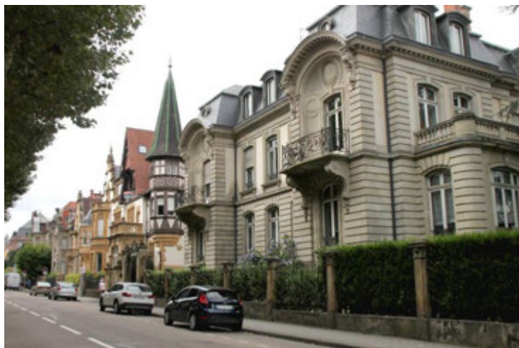
Diversité et charme pittoresque des villas cadrant la partie Nord de l'avenue Foch
