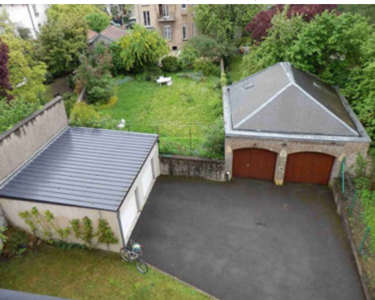
Des garages anciens et des garages récents dans un ancien jardin.
