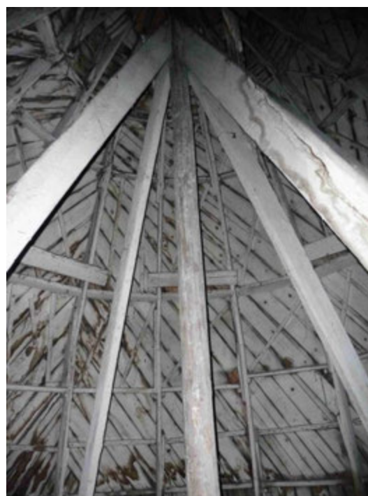
Exemples de charpentes vues dans la Nouvelle-Ville, réalisées en pin. Les fermes reposent sur une dalle de béton (en haut à gauche), elles peuvent aussi disposer de moises lorsque l'on a tenté d'aménager l'espace sous les combles (en haut à droite et ci-dessus à gauche). L'espace disponible reste généralement très réduit. Le sol des combles peut être en béton (dalle) ou en bois (plancher).
