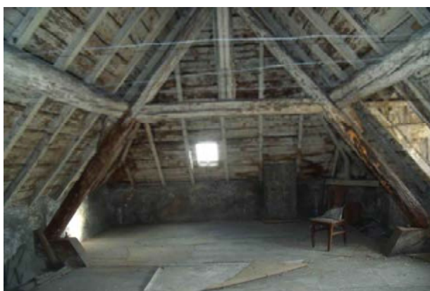
Exemples de charpentes messines courantes (26 rue du Neufbourg, multiples supports nécessaires pour une noue ; 30 place Saint-Louis, faible pente, réalisation traditionnelle. Ci-contre, au 4 rue Saint-Vincent, un exemple de charpente messine pour une couverture à forte pente.
