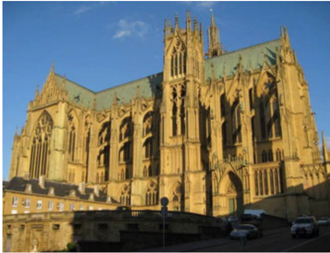
Cathédrale Saint-Etienne. La vue sur cet édifice majeur est particulièrement saisissante depuis la place de Chambre. Les grands degrés du terre-plein Saint-Etienne et la rampe formée par la rue d'Estrées permettent de relier les rives de Moselle au cœur de la ville. La physionomie actuelle de la cathédrale est héritée du XIX e siècle, suite à l'achèvement de la tour du Chapitre (1843) et au relèvement de la toiture (1882).
