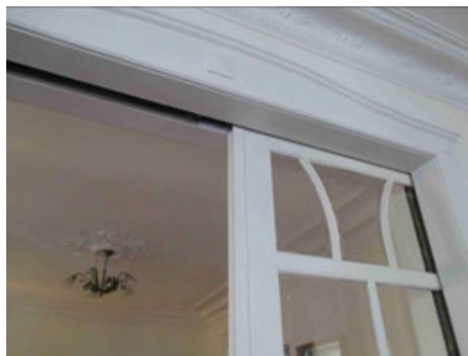
Exemples de vantail de porte et de contrevent coulissants.
