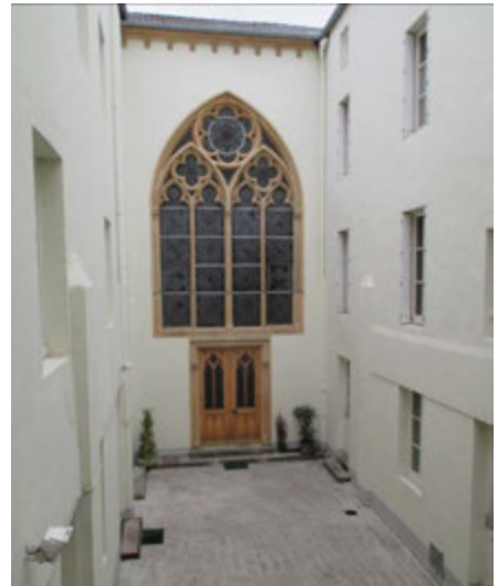
1, rue Châtillon. La cour de cet immeuble correspond à la nef de l'ancienne église Saint-Gengoulf dont les piliers sont visibles. Une chapelle a été créée au XIX e dans l'aile Nord.
