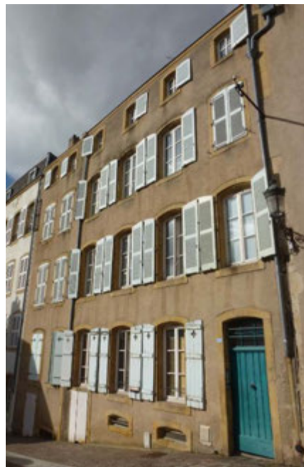
7 rue des Murs
