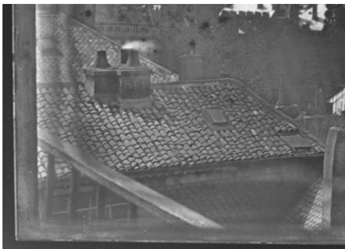
La tuile canal couvrait traditionnellement les maisons messines dont les toits ont de faibles pentes, ici place de Chambre. (© Fonds Prillot, médiathèque de Metz Métropole).
