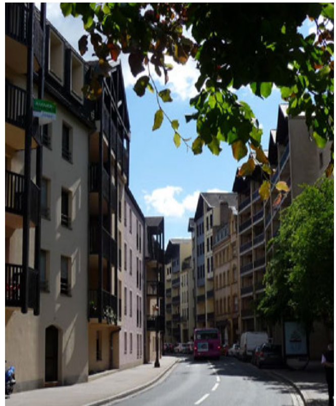
Les deux rives de la rue des Tanneurs, programme de reconstruction du début des années 1980 pastichant les anciennes maisons à galeries de bois.
