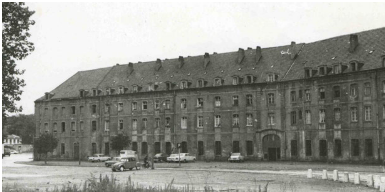
Ancienne caserne Chambière (détruite), dans le quartier du Pontiffroy. On observe une parenté structurelle et stylistique évidente entre les casernes messines du XVIII e siècle et les immeubles à loyer de la même période.
