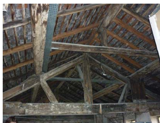
Exemples de charpentes messines courantes (26 rue du Neufbourg, multiples supports nécessaires pour une noue ; 30 place Saint-Louis, faible pente, réalisation traditionnelle. Ci-contre, au 4 rue Saint-Vincent, un exemple de charpente messine pour une couverture à forte pente.
