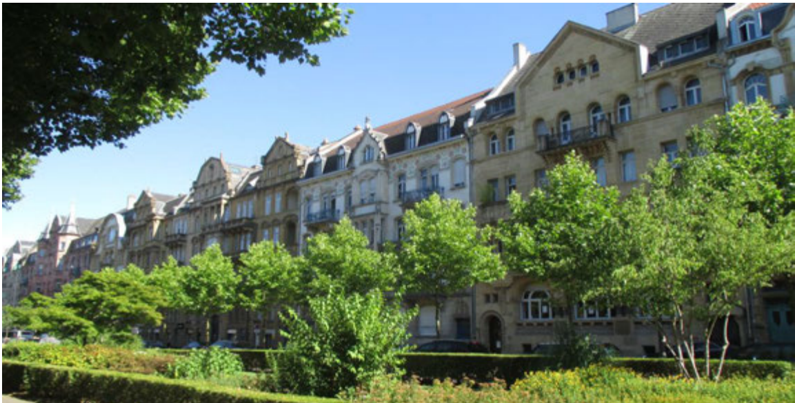
La rive Sud de l'avenue Foch comporte, dans la Neustadt, les grands immeubles résidentiels ou commerciaux les plus emblématiques des productions architecturales de l'Annexion à Metz.
