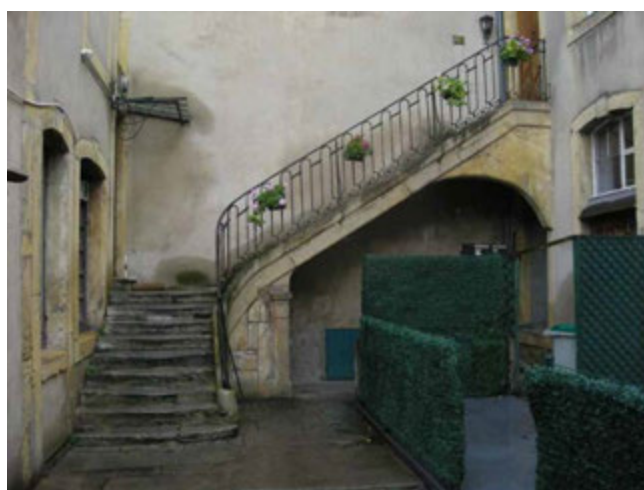
Exemple de cour accessible depuis la rue, où se situe un escalier extérieur ouvert à l'air libre, permettant de rejoindre directement le premier étage. La distribution des autres étages se fait en œuvre. Ce type est l'une des spécificités observables à Metz.
