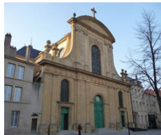
L'église Notre-Dame-de-l'Assomption, ancienne chapelle du collège jésuite avant la Révolution. La façade est achevée en 1739.
