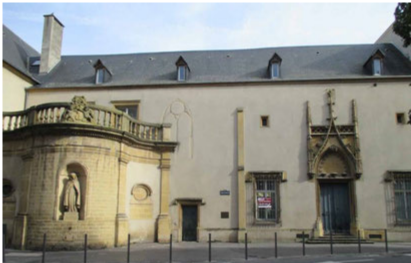
Ancien hospice Saint-Nicolas. L'aile Ouest présente encore des vestiges gothiques. La fontaine publique a été ajoutée au XVIII e siècle.
