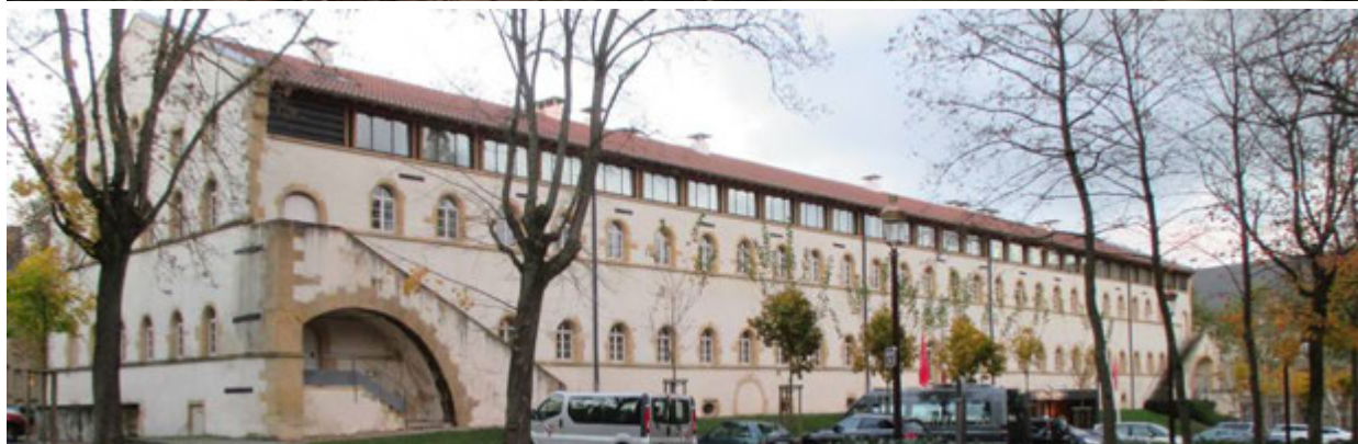
Le magasin aux Vivres, actuellement transformé en hôtel de luxe, après une campagne de travaux en 2005.
