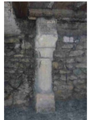
6 rue du Pont-Moreau
