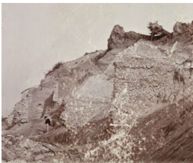
Vestiges des maisons sacrifiées par le maréchal de Scépeaux de Vieilleville lors du remblaiement précédent la construction de la citadelle (1902). © Bibliothèque-Médiathèque de Metz, fonds Prillot.
