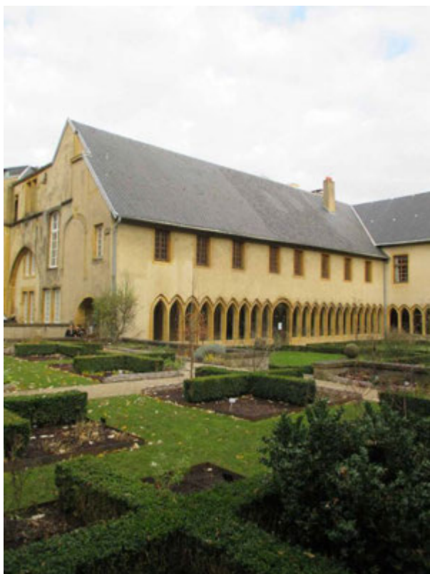
Ancien couvent des Récollets, au 1, rue des Récollets. Ce monument emblématique de Metz a été l'objet d'une opération de façadisme lors de son aménagement en équipement en 1972. A l'exception des façades protégées à la même date, d'éléments lapidaires conservés dans les galeries du cloître et de la salle capitulaire (non protégée), les intérieurs ont été très profondément remaniés et la façade sur la rue des Murs totalement reconstruite.
