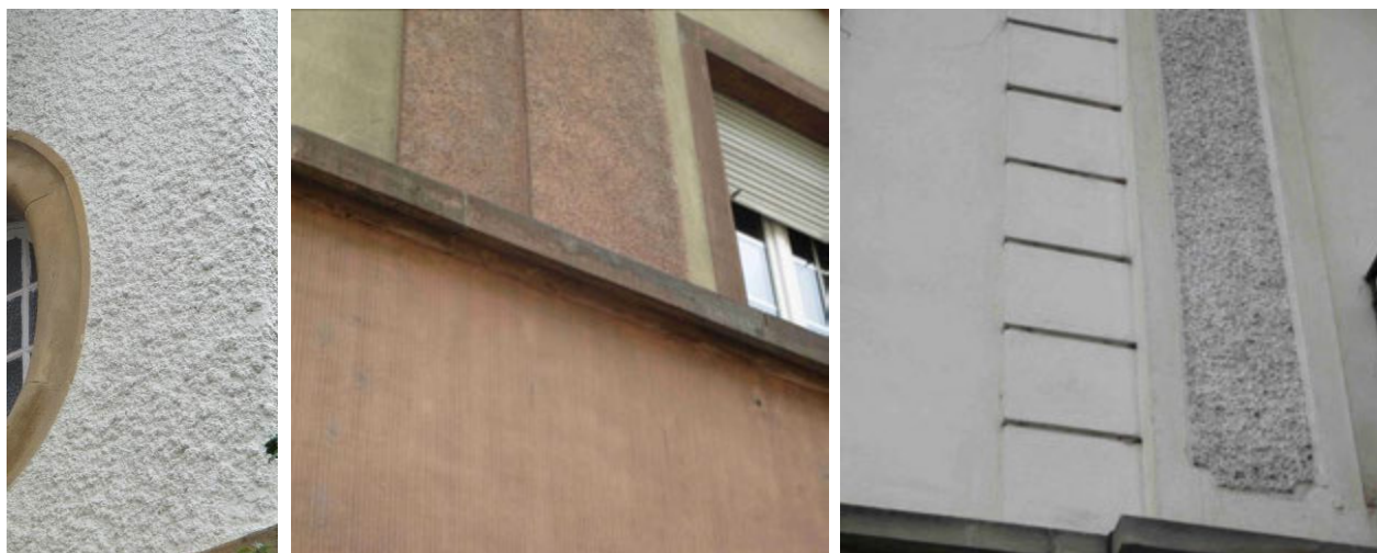
Enduit à forte rugosité posé à la tyrolienne (à gauche) ; enduit strié à rez-de-chaussée et enduit rustique sur pilastres (au centre) ; fausse chaîne à joints-refends réalisée sur l'enduit frais et plate-bande à la tyrolienne (à droite).
