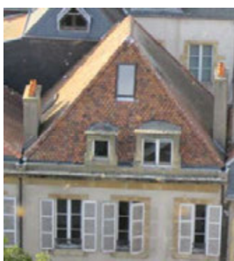
Couvertures à trois ou quatre versants à pentes fortes et étage d'attique à droite, tuile mécanique à double côte et vastistas anciens à gauche, ardoise écaille et petites lucarnes bois ajoutées dans le versant à droite.
