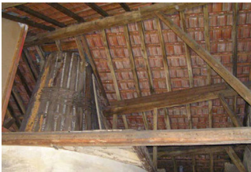
Exemple de charpente très reprise intégrant le cône d'éclairage zénithal de la cage d'escalier, réalisé en lattis plâtré (10 rue Maurice-Barrès). Les irrégularités observables dans l'implantation des pannes sont dues au rattrapage nécessaire de la forme trapézoïdale du bâtiment.
