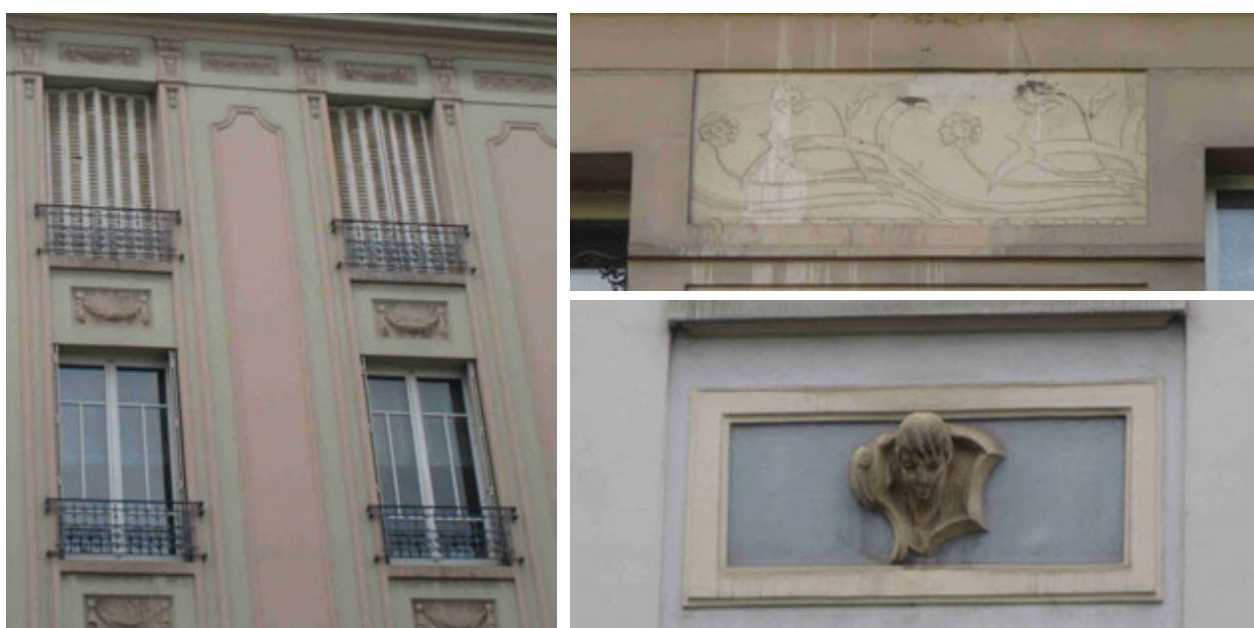
Enduit moulé en ciment, remplaçant généralement à partir des années 1920 les parties traditionnellement sculptées sur les façades dans la Nouvelle-Ville : plates-bandes et guirlandes (à gauche) ; relief en creux dans le goût Art nouveau (ci-dessus en haut) ; buste de jeune homme sur un immeuble Modern style (ci-dessus en bas).
