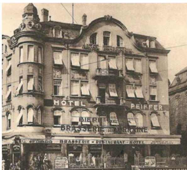
Rabotage du décor en relief et des balcons (ici sur l'ancien hôtel « Elsäßer Hof », où le décor disparu est visible sur une carte postale ancienne).
