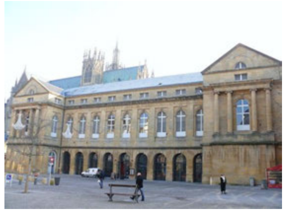
Marché couvert, vu du côté de la place de Chambre. Destiné à abriter le nouveau palais épiscopal et resté inachevé en raison des événements révolutionnaires, il est décidé de l'affecter à un marché au XIX e siècle. Il est donc achevé selon les exigences de ce nouveau programme. Le contraste est saisissant avec la cathédrale, ce qui aurait été également le cas si le palais épiscopal avait été réalisé.
