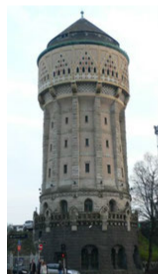
Le château d'eau de la gare (1908) marque la limite Nord du complexe ferroviaire.
