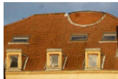
Couverture en tuiles à ondes douces, lucarnes altérées, châssis de toit récents en second rang, émergence de la cage d'escalier ayant perdu son lanterneau.
