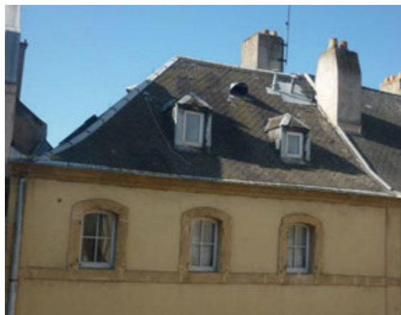
Couvertures à trois ou quatre versants à pentes fortes et étage d'attique à droite, tuile mécanique à double côte et vastistas anciens à gauche, ardoise écaille et petites lucarnes bois ajoutées dans le versant à droite.
