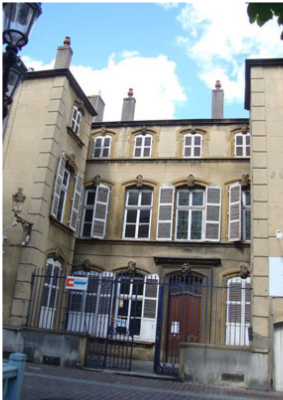
50, rue Mazelle. Hôtel particulier du XVIII e siècle avec parties plus anciennes sur cour, qui a apparemment appartenu à la famille de Gournay-Carré de Malberg.
