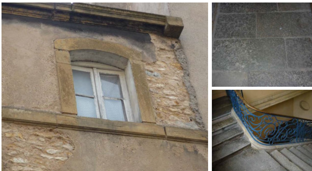
Trois exemples d'usage du calcaire blanc : moellons en maçonnerie sur les façades (couplés à du Jaumont pour les encadrements et bandeaux) ; dallage pour des halls ou couloirs ; emmarchements pour des volées d'escalier en pierre.
