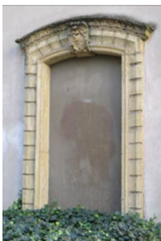
10-12, rue de la Haye. Porte XVIIIe remontée devant l'immeuble.
