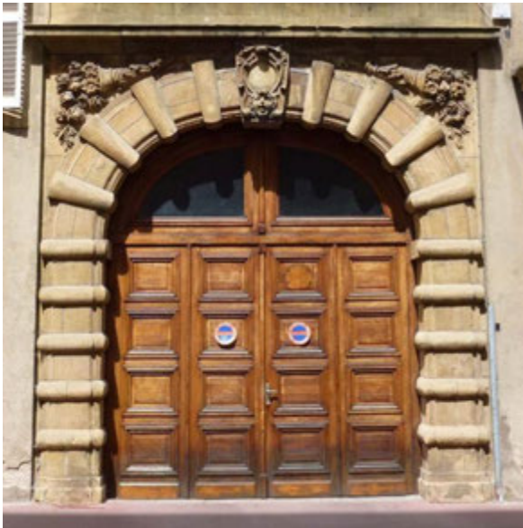
Porte XVIIe, protégée M.H., de l'hôtel de la Bulette, remontée au 6 rue des Récollets.
