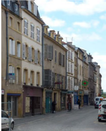
Rue du Pont-des-Morts, maisons sur parcellaire laniéré.
