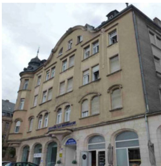
Rabotage du décor en relief et des balcons (ici sur l'ancien hôtel « Elsäßer Hof », où le décor disparu est visible sur une carte postale ancienne).
