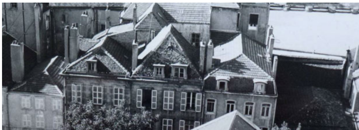
Evolution des couvertures et de leurs percements : rue Sous-Saint Arnould, vues prises de la vigie du cercle des Officiers. En haut, photo actuelle, en bas, années 1960 (archives STAP).
