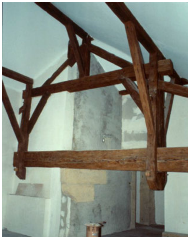
Exemples de charpentes messines traditionnelles visibles aux 4 et 9 rue des Murs (ici au 9, à l'hôtel de Malte, à gauche) et dans l'hôtel de Burtaigne, au 4 place des Charrons (à droite).
