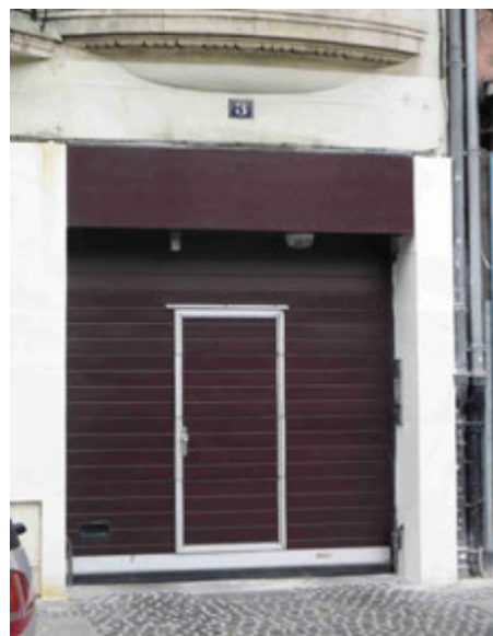
Rabotage d'éléments sculptés et pose d'un enduit inapproprié (à gauche), pose de menuiseries en PVC de série en rupture avec l'écriture architecturale (au centre), remplacement des vantaux et du portillon d'une porte cochère par un dispositif non qualitatif.
