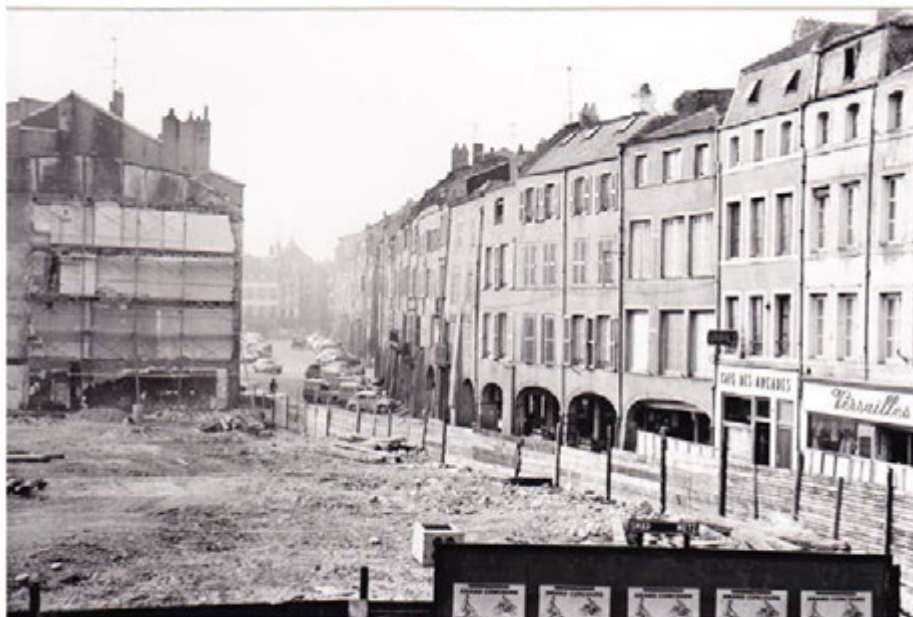
Démolition de l'îlot du Change, 1964, photographie service régional de l'inventaire
