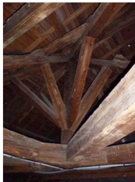
Exemple de charpente (au 1 rue Haute-Pierre) dont l'enchevêtrement permet un grand dégagement de l'espace disponible sous les combles.
