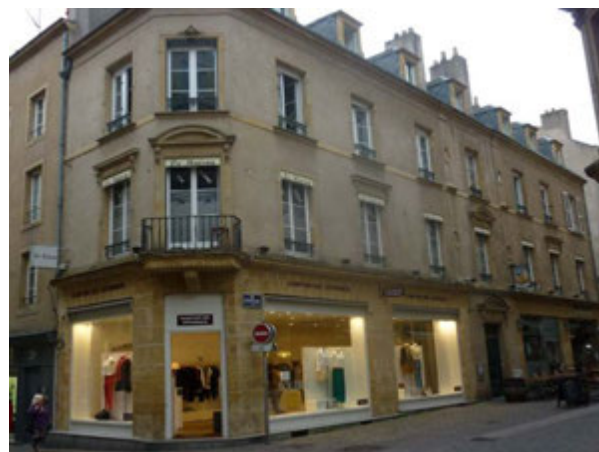
2, rue Dupont-des-Loges. Immeuble « placard ».
