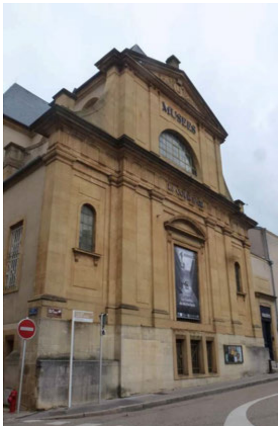
La chapelle des Grands-Carmes a abrité, après la Révolution, la Bibliothèque municipale. Elle est aujourd'hui entièrement dévolue aux musées de la Cour-d'Or. Le perron donnant sur la rue du Haut-Poirier a été supprimé dès le XIX e siècle lors d'un réaménagement de l'espace public.
