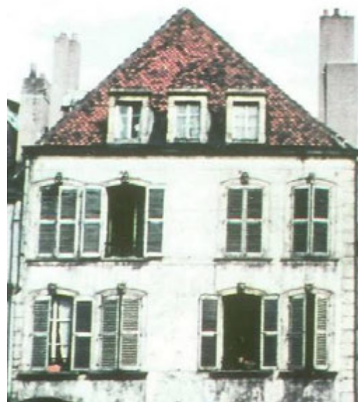
Les toits à forte pente recevaient traditionnellement de la tuile plate écaille (et de l'ardoise écaille sur le brisis), ici sur l'hôtel Le Brun (22 rue de la Chèvre) et la maison La Roche (20 rue de la Chèvre), immeubles détruits dont des éléments des façades ont été remontés en Fournirue. (Archives du STAP de Moselle).
