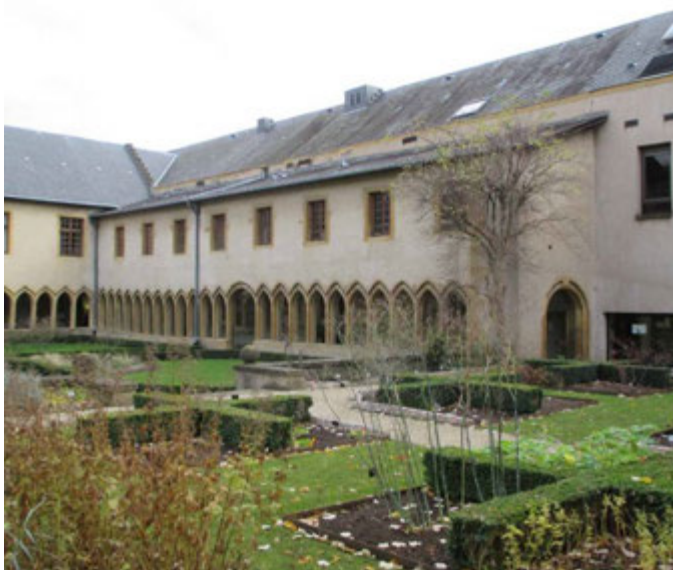
Intérieur du cloître du couvent des Récollets. Les bâtiments abritent l'Institut européen d'écologie.
