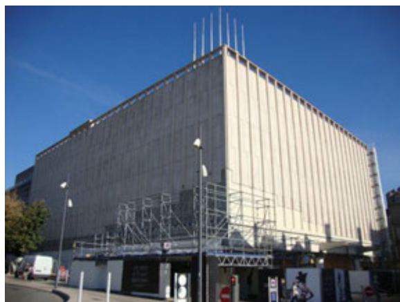
25, rue des Clercs. Galeries Lafayette. Rupture d'échelle.
