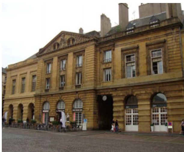
Façade de l'ancien parlement des Trois-Evêchés. L'homogénéité est légèrement rompue depuis les entresolements pratiqués au XIX e siècle pour lotir l'ancien palais public. La vue depuis la place d'Armes est gâchée par la présence d'aubettes entre les trophées monumentaux.
