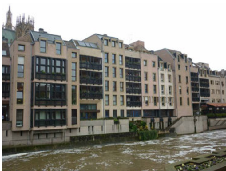
Les Roches, ensemble immobilier construit en 1980 par Claude Charpentier, Albert Longo, Robert Ochs et Jean Bigard.
