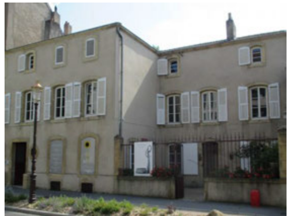
10, rue des Bénédictins. Immeuble-type, avec cour sur rue, de l'opération de lotissement de La Villeneuve-d'Outre-Moselle.
