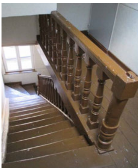
Escalier rampe sur rampe en œuvre distribuant les étages supérieurs, lambris toute hauteur et placard à panneaux moulurés XVIII e siècle.
