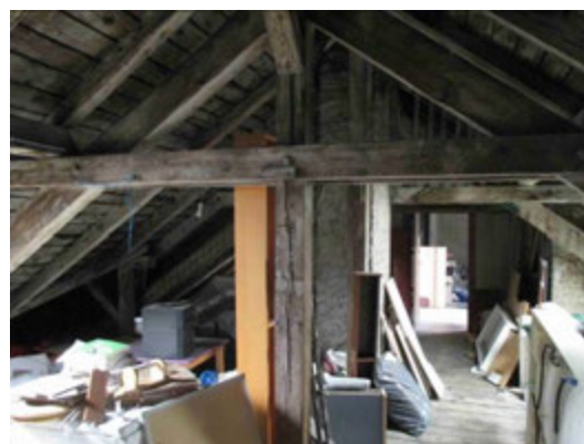
Exemple de charpente très reprise intégrant le cône d'éclairage zénithal de la cage d'escalier, réalisé en lattis plâtré (10 rue Maurice-Barrès). Les irrégularités observables dans l'implantation des pannes sont dues au rattrapage nécessaire de la forme trapézoïdale du bâtiment.
