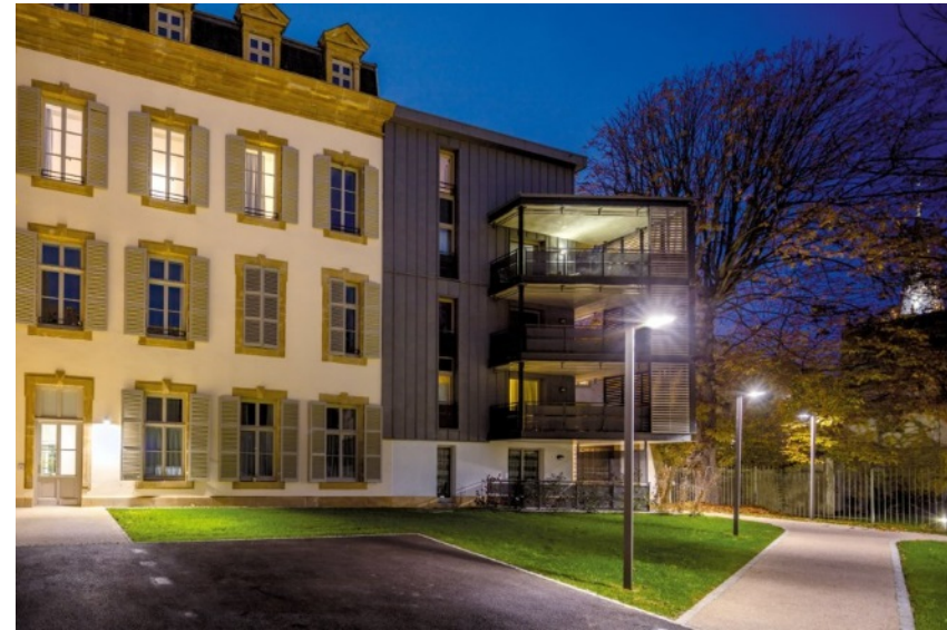
Ancienne maternité Sainte Croix : extension neuve Architecte : M. Klein
