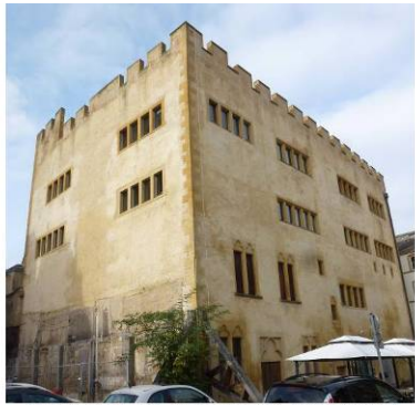
7, rue des Piques. La grange des Antonistes vue depuis la cour.
